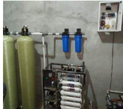
Gambar 13. Pemasangan Sistem Kelistrikan
