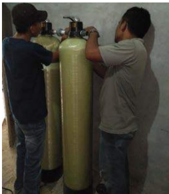
Gambar 11. Pemasangan Tabung Filter Makro
