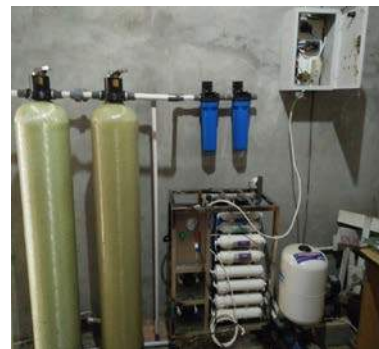
Gambar 14. Peralatan Utama Sudah Terpasang
