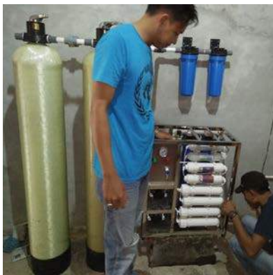
Gambar 12. Pemasangan Mesin RO
